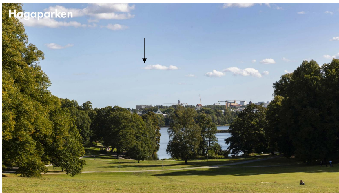
Figur 1. Bild med vy från Hagaparken. Pilen pekar på vattenreservoaren. Bildkälla: Wingårdhs.
